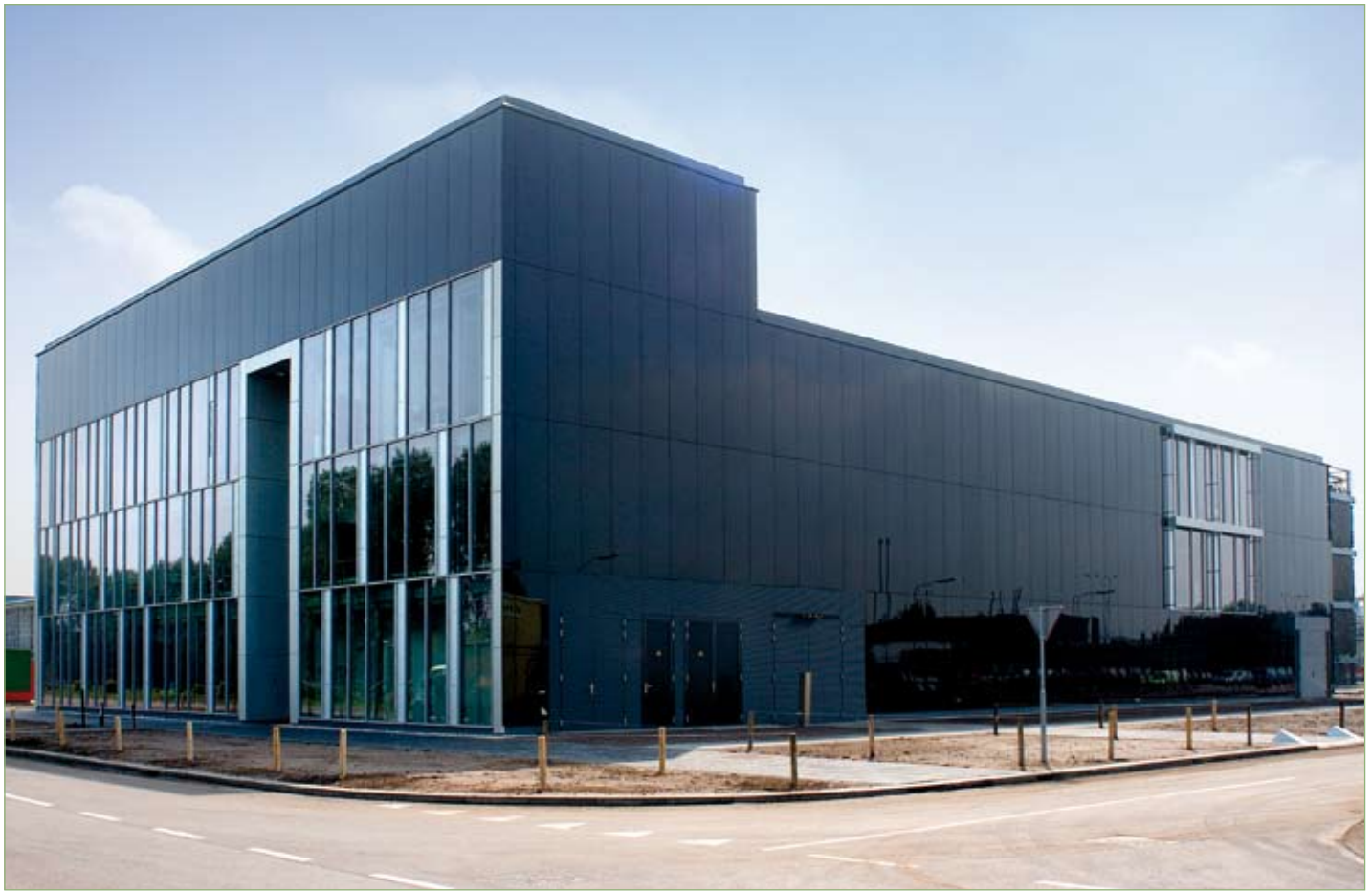
Afb. 4: Een typisch voorbeeld van een gebouw waar elektrotechnici, fabrikanten van installaties én mechanische en civiele technici hebben samengewerkt om EMC-problematiek te minimaliseren: het ElectroMagnetics and Cooling Competence Center in Eindhoven.
